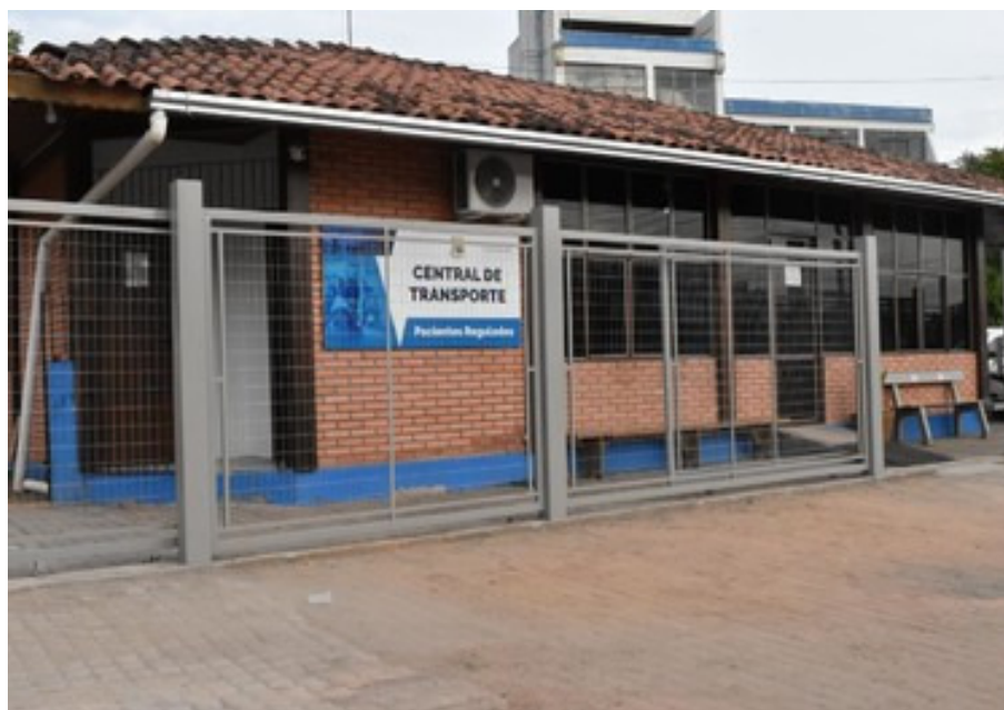
Figura 13: Fachada da Central de Transportes
